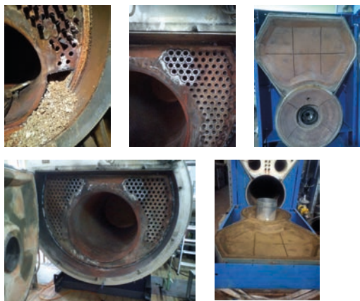
Schweißarbeiten und Schamottierung
