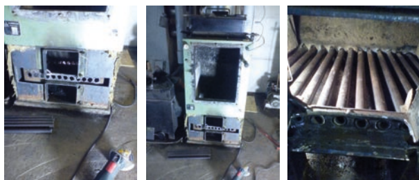
Demonatage und Montage der Rohre
